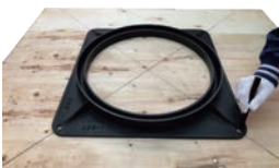
1. 受枠を施工位置に置き、アンカー孔位置に印を付ける。
