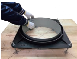
4. 受枠に型枠を入れ、止め板を曲げ端部を固定する。
