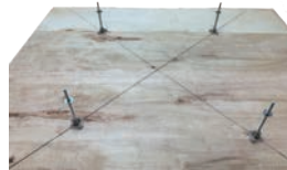
2. レベルボルトをアンカー孔位置に釘止め固定する。
