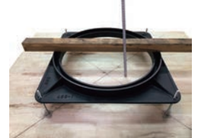
3. 受枠をレベルボルトにセットし、ナットを回し仕上げレベルに合わせる。
