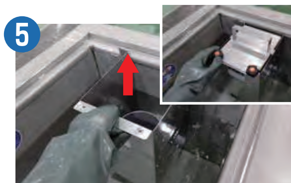
封水キャップまたは、トラップキャップをはずした後、仕切板を取り外し、トラップ管を掃除します。(2～3ヶ月に1回以上)
