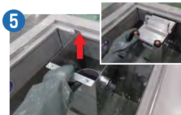
5 封水キャップまたは、トラップキャップをはずした後、仕切板を取り外し、トラップ管を掃除します。(2～3ヶ月に1回以上)
